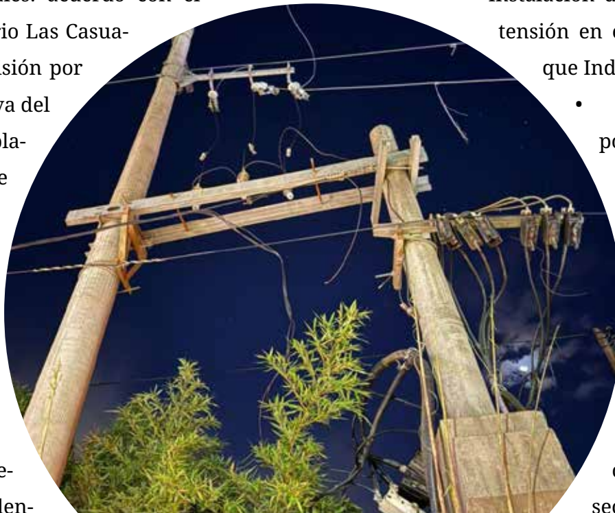
MANTENIMIENTO. Trabajos nocturnos para garantizar la continuidad y seguridad del servicio eléctrico.
