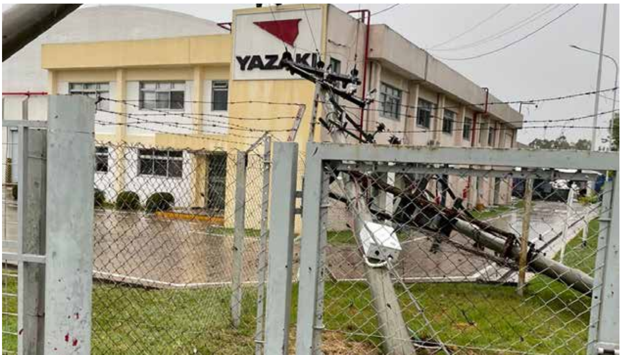
POSTES CAÍDOS. Las fuertes ráfagas de viento produjeron un significativo daño a la infraestructura.
