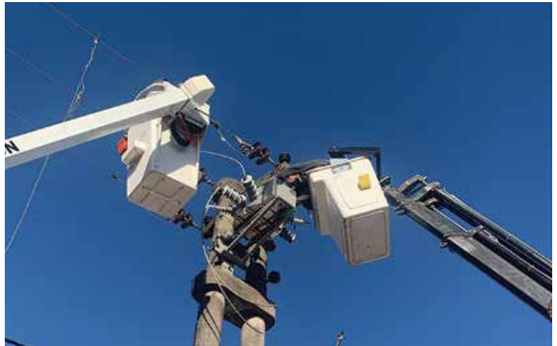
MANOS A LA OBRA. Personal de la Cooperativa instaló los nuevos seccionadores.
