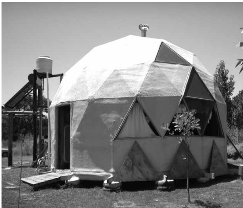
SINGULAR. La estructura de la casa está apoyada sobre gomas de auto y tirantes.
