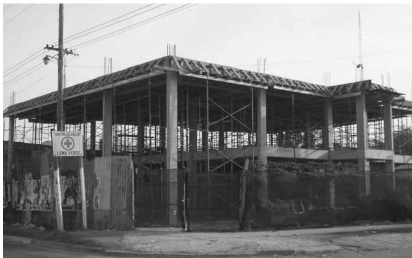
PROGRESO. En apenas cuatro meses, la construcción avanzó significativamente.
