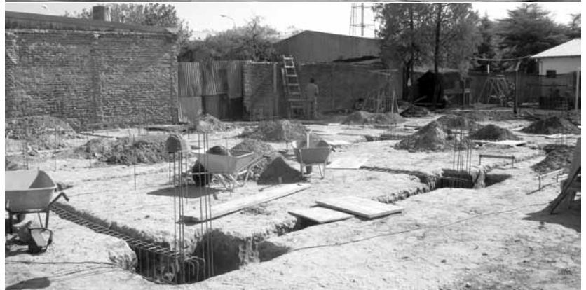
OBRA EN MARCHA. La primera etapa del hormigón estaría terminada antes de agosto.
