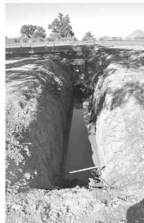
La tubería atraviesa Loma Verde, pasa bajo la autopista y llega hasta Cardales.
