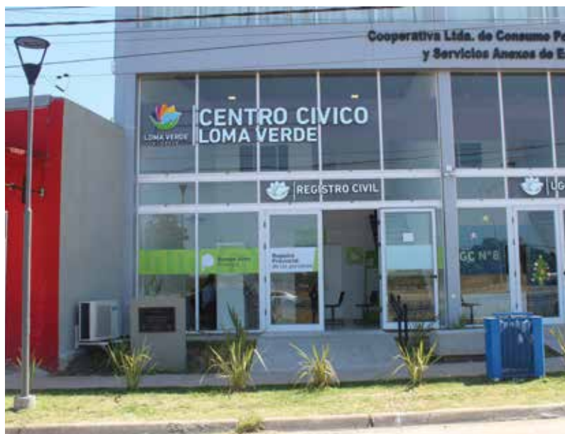
CENTRO CIVICO. Funciona en la planta baja del edificio de la Cooperativa.
