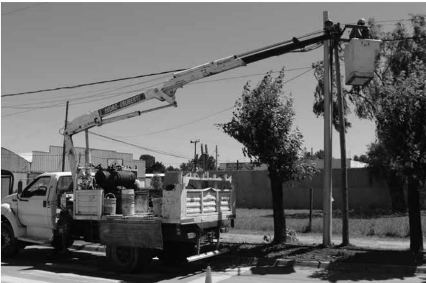
**TRABAJOS EN ALTURA.** Renovación del tendido, cambio de postes y poda correctiva.
