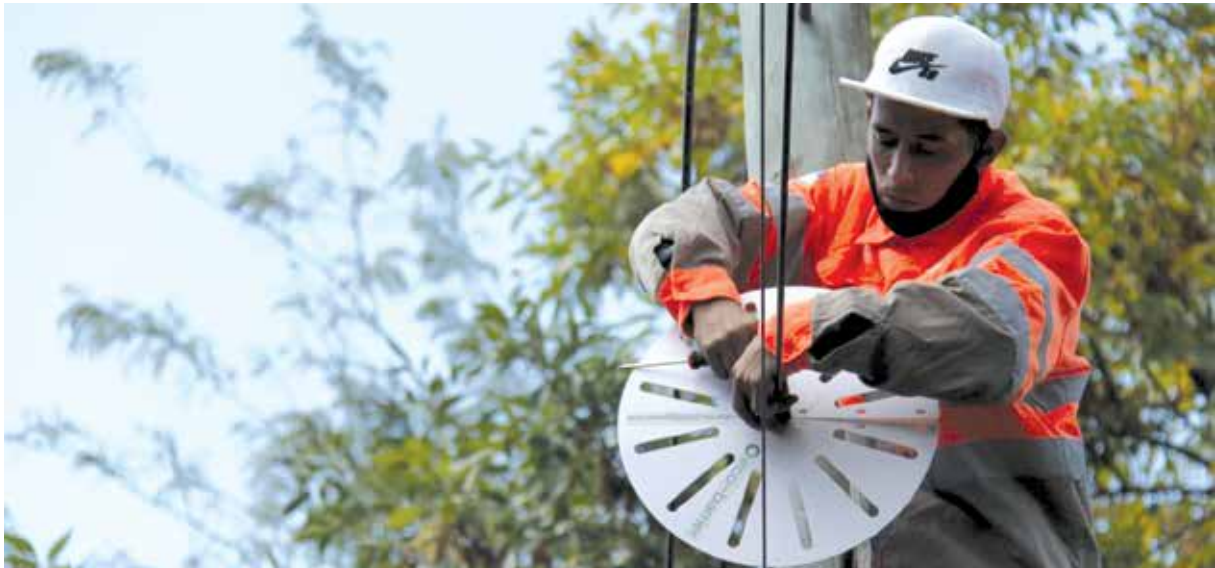
PRUEBA PILOTO. La Cooperativa ya colocó unos 200 artefactos Eco-Barrier en el cableado del lado oeste de la autopista.
